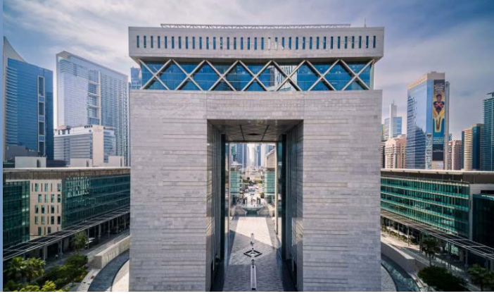
Emiratos Árabes Unidos. DIFC Tunnel
