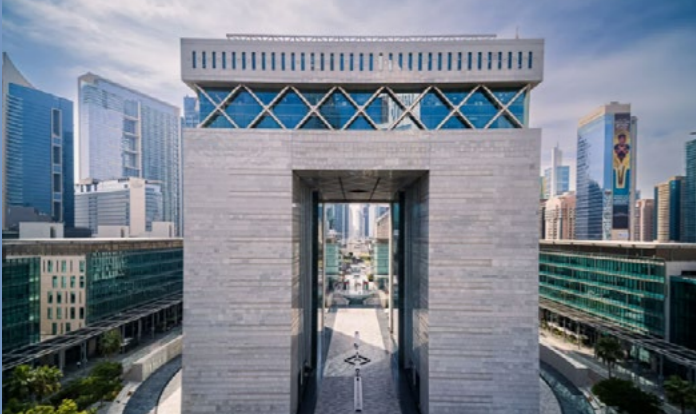
Émirats Arabes Unis. DIFC Tunnel
